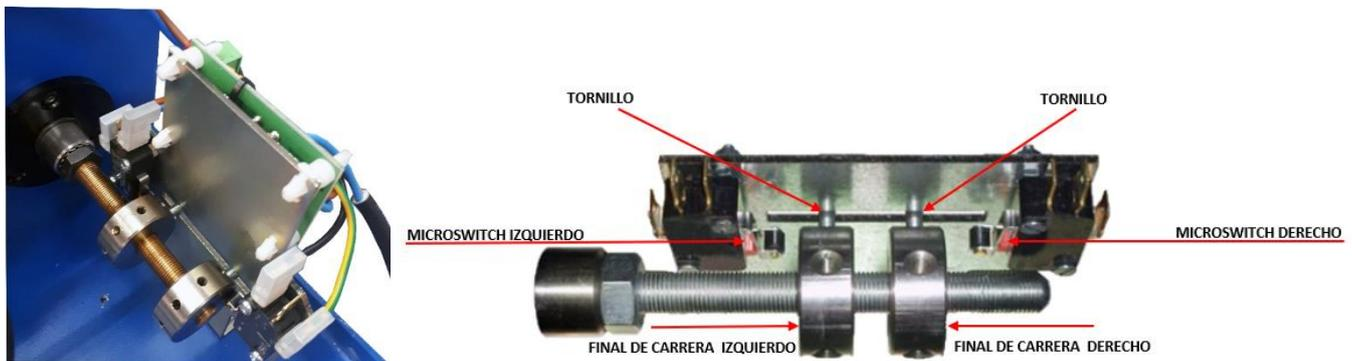
**EL AJUSTE DE LOS TOPES MECÁNICOS SE HACEN** a la vez que la programación de los finales de carrera electrónicos con el fin de sincronizar el recorrido de las entradas de aire. Ver: El manual de instrucciones del regulador correspondiente al motor.
