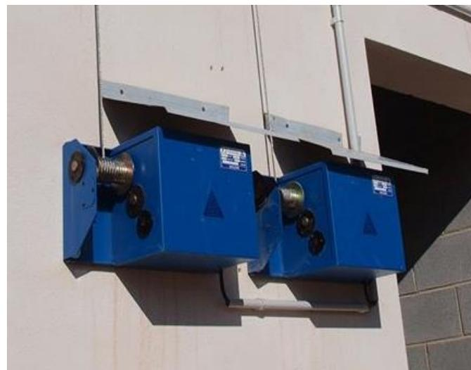
**Evitar fijar el motor en un lugar húmedo** o con posibilidad de verter algún líquido sobre él. Si no se puede evitar, **protegerlo todo lo posible** (con un tejadillo, o con algún tipo de carcasa adicional de protección, por ejemplo)
